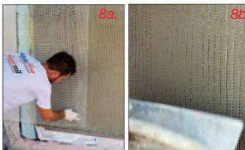
9. Splamare l'intera superficie con un'ulteriore mano di Rasante Aquafire® come lisciatura, lavorando in senso orizzontale.
