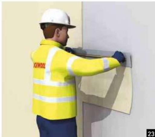
Controllare attentamente le condizioni meteorologiche, per garantire una corretta asciugatura in modo da evitare disomogeneità nella colorazione della superficie. La temperatura non dovrà essere inferiore a +5 °C per REDArt Finitura Siliconica e a +8 °C per REDArt Finitura ai Silicati. La temperatura non dovrà essere superiore a +30°. Evitare il rischio di gelata per le prime 48 ore dopo la stesura. Proteggere adeguatamente la facciata da pioggia, vento ed esposizione solare.
