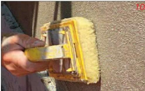
11. Applicare una mano di primer isolante per esterni prima di procedere alla tinteggiatura diretta con pittura acril-silossanica al quarzo o alla posa dell'intonachino acrilico, acril-silossanico o silossanico.
