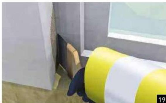
**Profilo di unione per telai di porte e finestre autoadesivo** (figura 19), con linguetta protettiva e rete di armatura o in alternativa nastro di guarnizione autoespandente.
