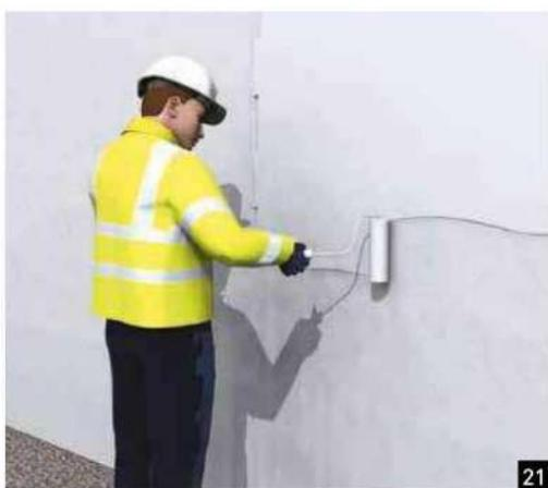
Per garantire un'ottima adesione, è necessario trattare la superficie dello strato di rasatura armata con un fissativo prima di applicare la finitura.
