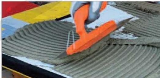
4. Spalmare il Rasante Aquafire® sul pannello con frattazzo dentato da 10mm.
