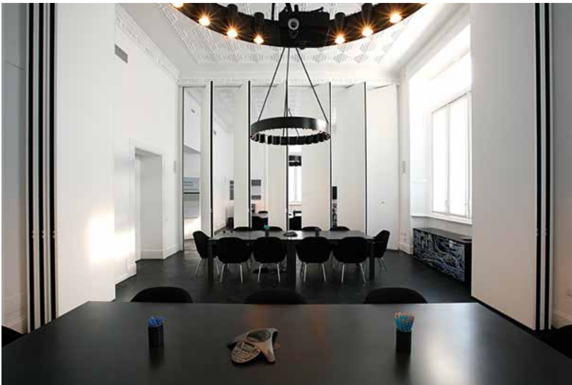
PANNELLI MANOVRABILI IN POSIZIONE SEMI APERTA.
