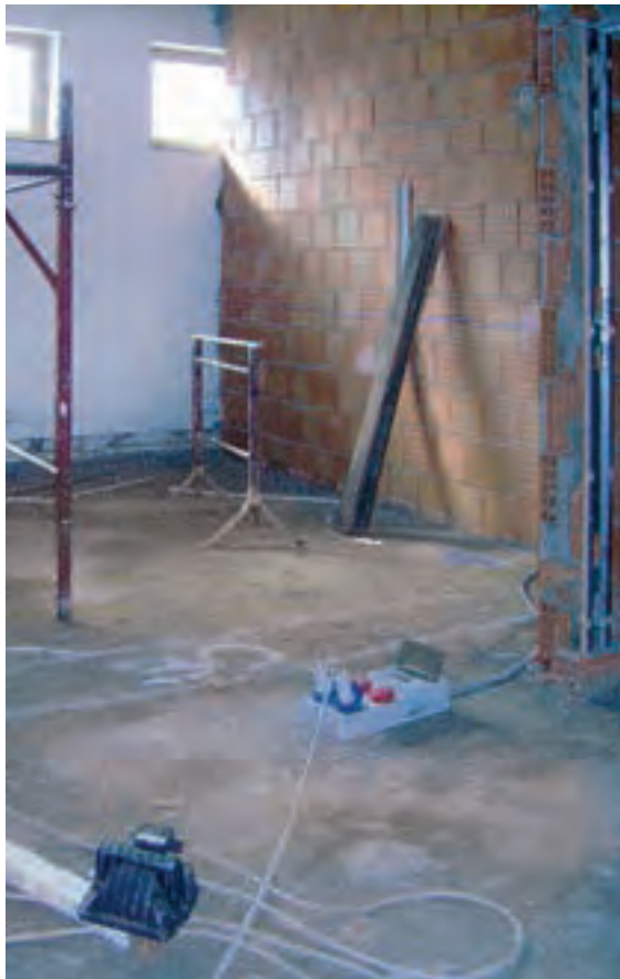
I muri, in cattive condizioni, sono stati stuccati, rimessi a piombo ed attrezzati con scatole elettriche a supporto del nuovo impianto elettrico.
