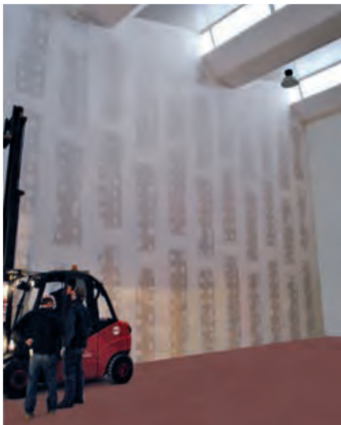
Fasi di realizzazione di una parete in cartongesso alta 11 mt., con elevate caratteristiche di resistenza al fuoco, di isolamento termoacustico e di antisismicità.
