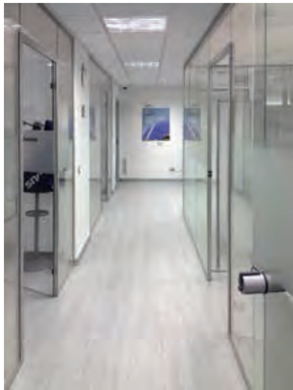
Controsoffitto in pannelli di fibra minerale con inserimento di corpi illuminanti antiriflesso.
