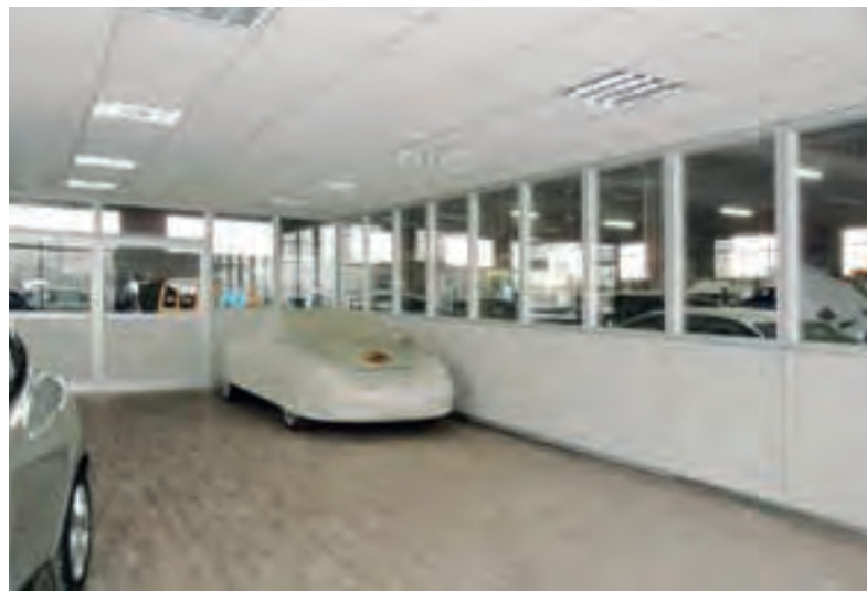
Controsoffitto in pannelli di fibra minerale con inserimento di corpi illuminanti antiriflesso.
