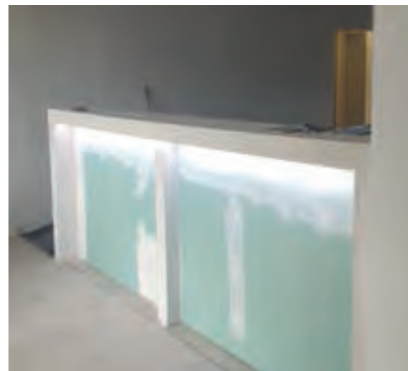
Bancone reception realizzato su progetto in cartongesso ed inserti luminosi.
