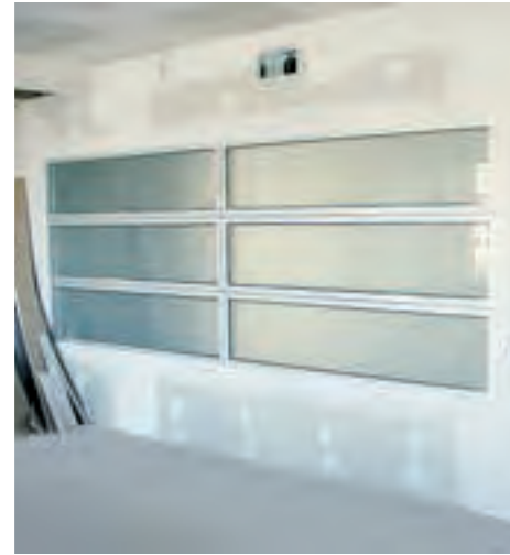
Stuccatura delle lastre e tinteggiatura delle pareti, con possibilità di inserimento porte ed elementi vetrati.
