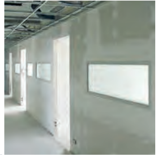
Stuccatura delle lastre e tinteggiatura delle pareti, con possibilità di inserimento porte ed elementi vetrati.
