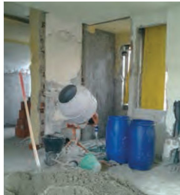
I muri, in cattive condizioni, sono stati stuccati, rimessi a piombo ed attrezzati con scatole elettriche a supporto del nuovo impianto elettrico.
