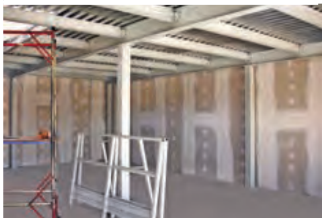
Tamponamento soppalco con cartongesso
