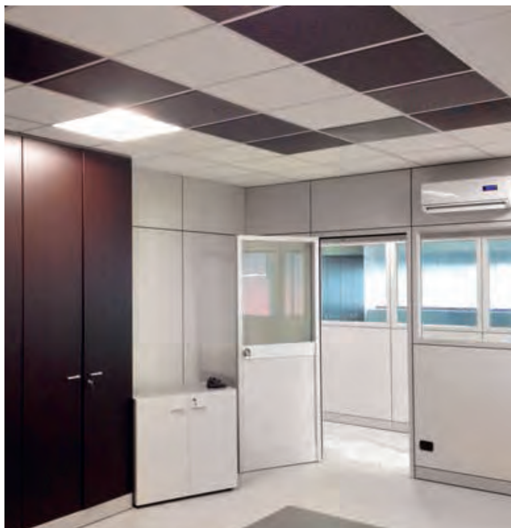
Controsoffitto misto realizzato con pannelli metallici.
