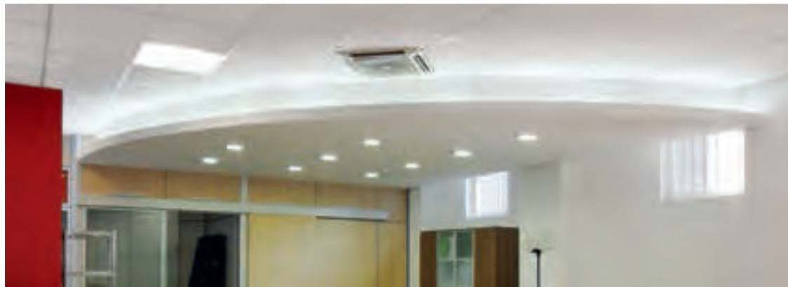
Le cornici del ribassamento ospitano apparecchi illuminanti che riflettono la luce sul soffitto. Il ribasso, ospita faretti a vista. I locali vengono illuminati con luce diretta o con luce riflessa, a seconda delle condizioni ambientali e delle attività svolte. Il controsoffitto è stato movimentato con volumi, ribassi e cornici, lo spazio ne risulta arricchito.
