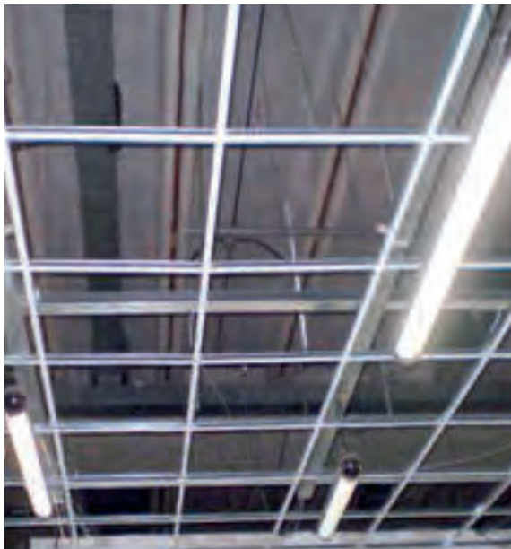
Dettaglio struttura portante
