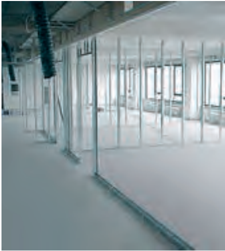
Posa struttura portante in alluminio, per parete in cartongesso.
