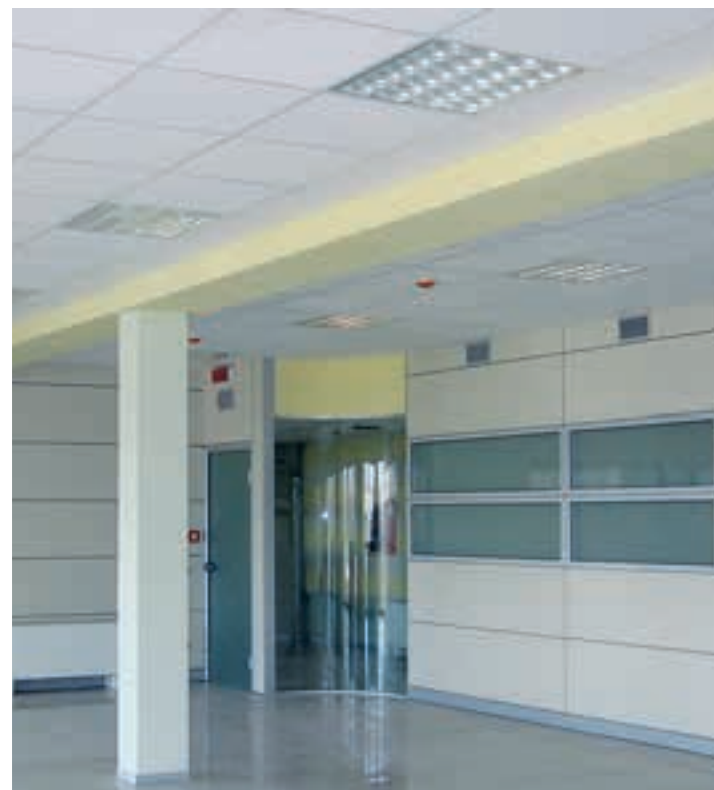
Controsoffitto in pannelli di fibra minerale con inserimento di corpi illuminanti antiriflesso.
