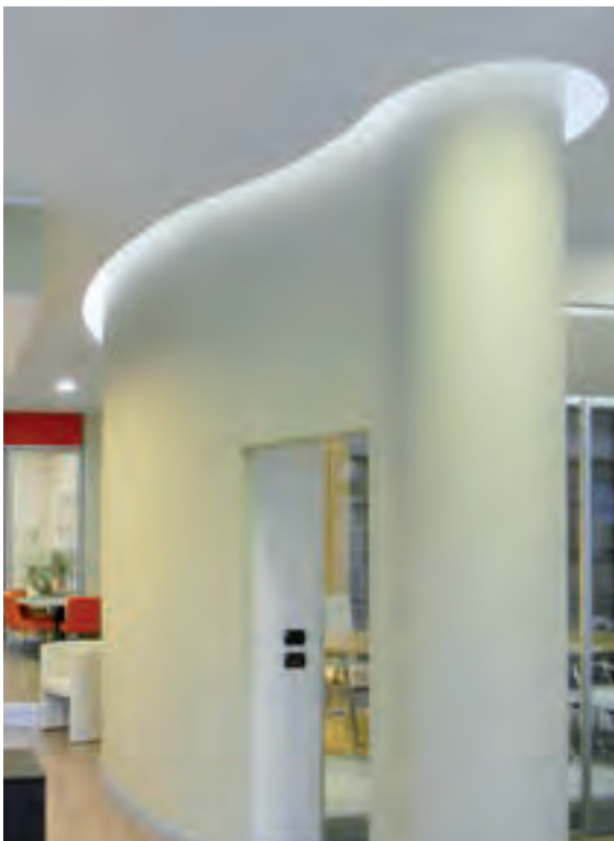
Fra i vantaggi del cartongesso, la possibilità di creare divisori, anche successivamente la posa del pavimento e del controsoffitto.
