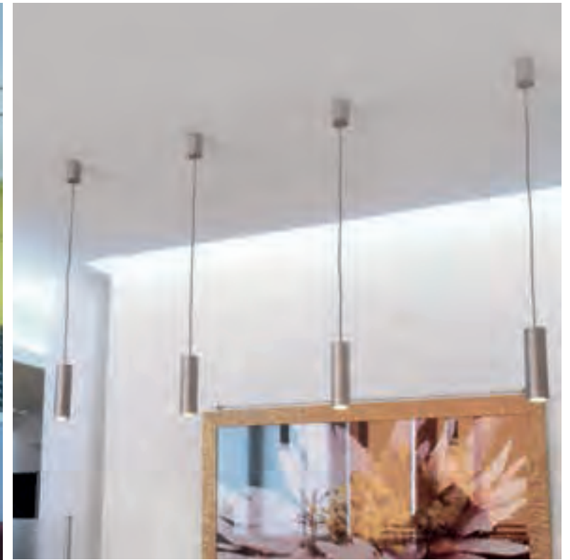
Gola in cartongesso distanziata dalla muratura perimetrale dove vengono ospitati corpi illuminanti nascosti. La lama di luce proiettata aumenta l'ampiezza e l'altezza dell'ambiente.
